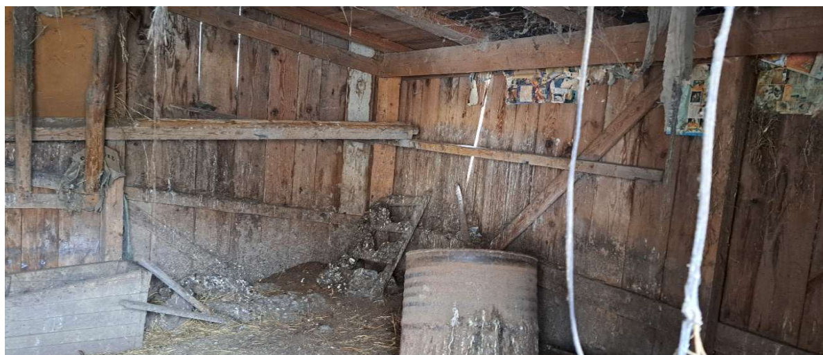
Pozemek, parc.č. 3856 - objekt k demolici -interiér.
