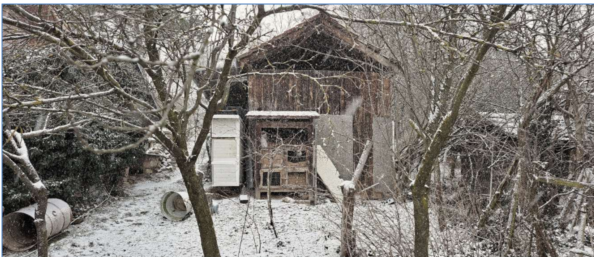
Pozemek, parc.č. 3856 - objekt k demolici.
