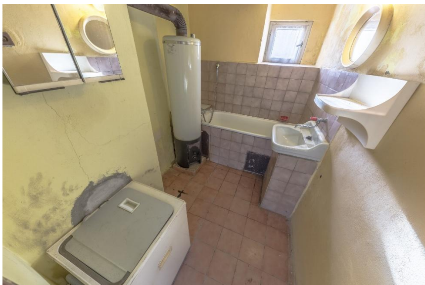
Koupelna s bojlerem na pevná paliva
