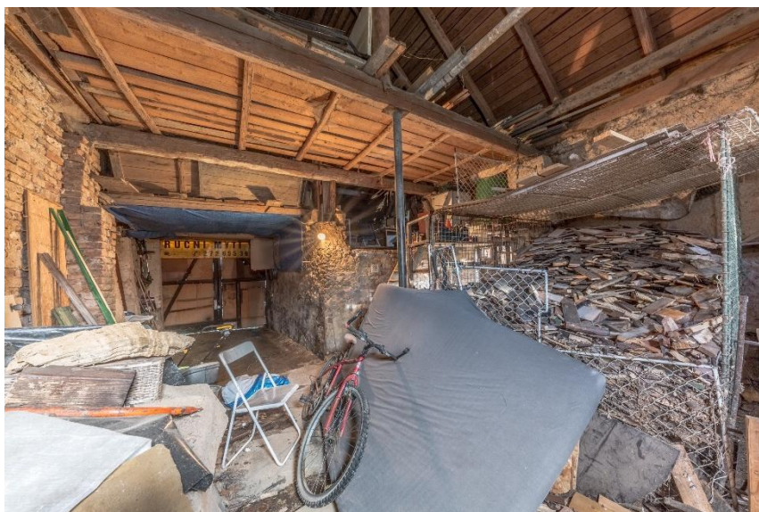
Hospodářský / půdní prostor — vhodný ke skladování, s potenciálem vestavby
